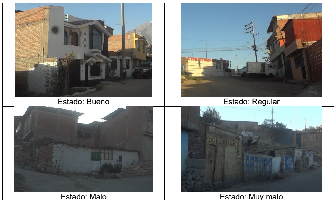
FOTO 9: Estado de la construcción en UPIS Alto Juan XXIII
