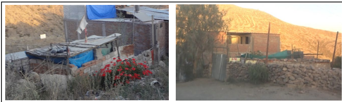
FOTO 5: Predios con material precario
