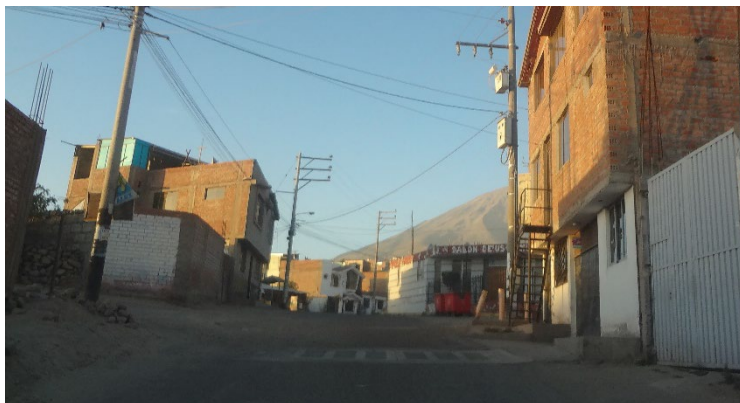
FOTO 13: Jirón 1 con asfalto y alcantarillado
