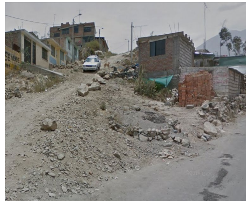
Vista de pendiente máxima al ingreso al sector
